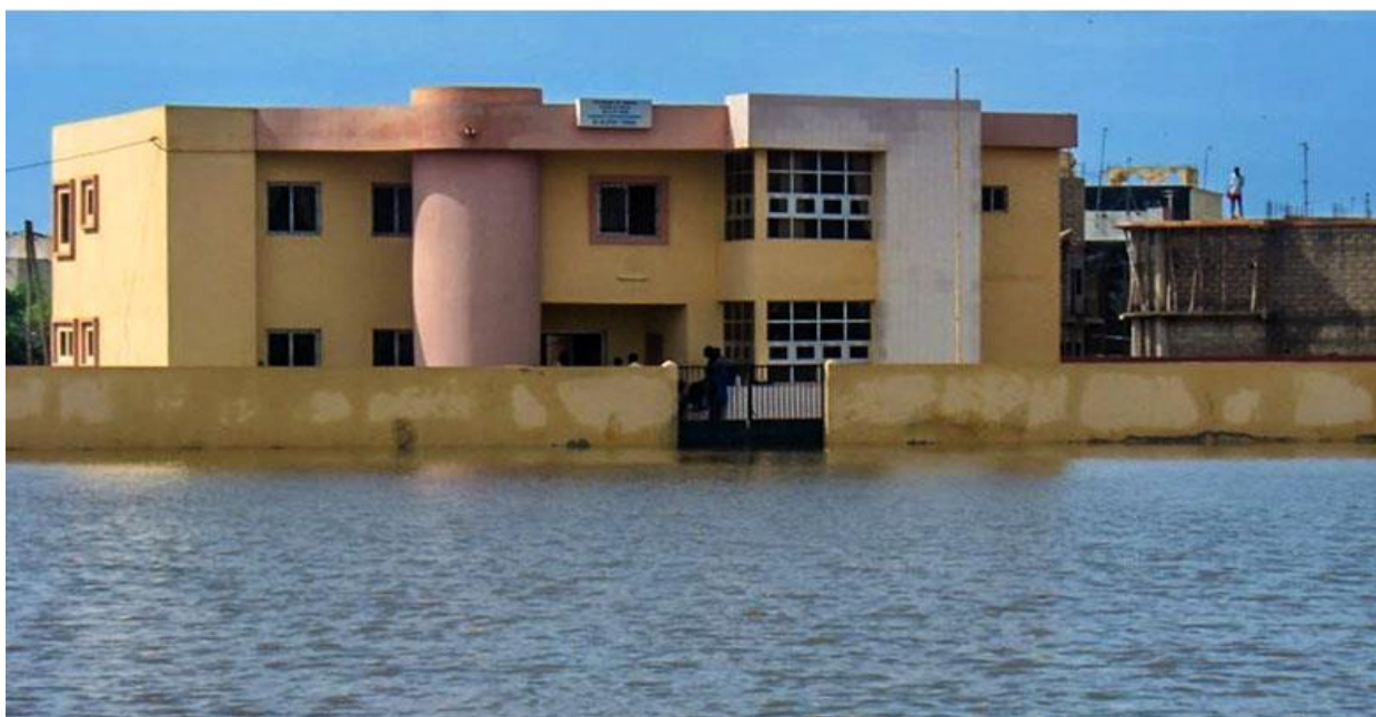
Photo 5 : La Mairie de Dalifort sous les eaux de pluie
