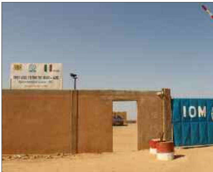
L'entrée des bureaux de l'Oim à Agadez.
